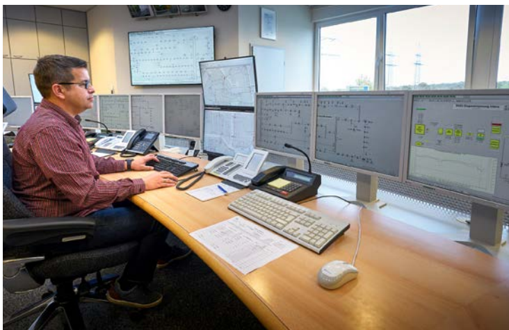
In der Netzleitstelle der LSW laufen alle wichtigen Netzdaten zusammen.
